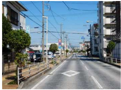
県道 188 号穂積停車場線 (JR 穂積駅南)
