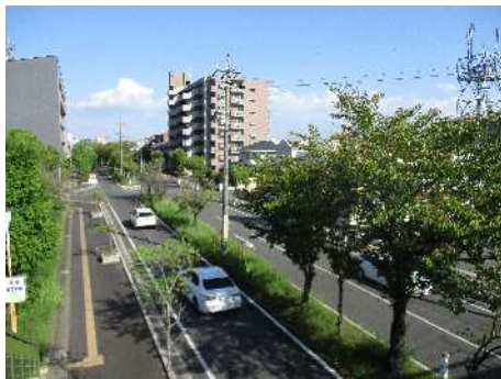
市道 4-1 号線 (瑞穂市役所穂積庁舎付近)
