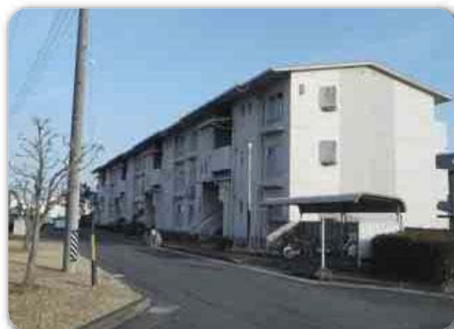
市営住宅(B棟)
