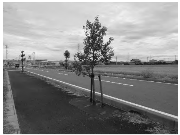
古橋、中宮地内(市道10-1号線)
