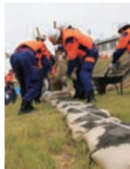
▲積み土のう工法
