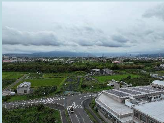
岐阜県南大野線バイパス
