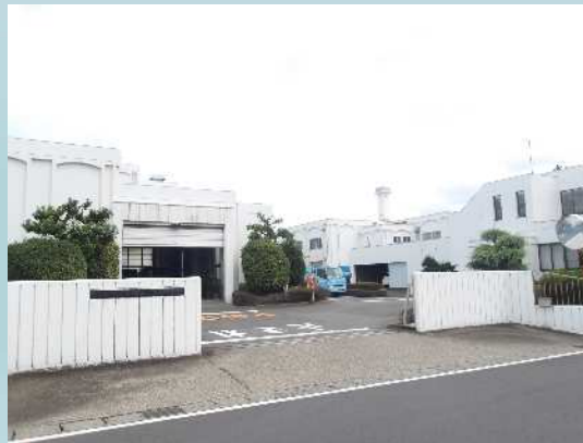
もとす広域連合衛生施設
