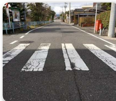
市道10-2号線(呂久地内)
