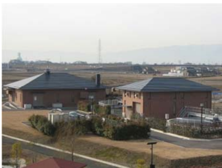
下水処理場、ストックヤード等
