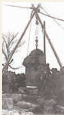
主碑の設置作業 重機はなく人力で作業
