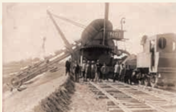
ドイツ製の大型掘削機械:ラダーエキスカベータ2台で開削 蒸気機関車とトロッキ:20トン(2台)・5トン(1台)で重機の移動と 土砂の運搬(新堤づくり、廃川の埋立)
