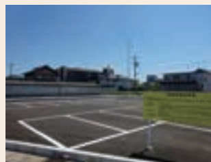
駅西会館駐車場整備
