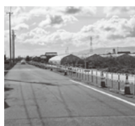
▲サンコーパレットパーク西側、南北状況 道路の整備状況(宮田・大月)
