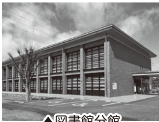
▲図書館分館 (西部複合センター)
