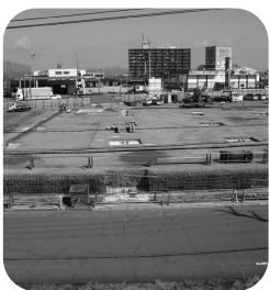
▲店舗進出工事場所
