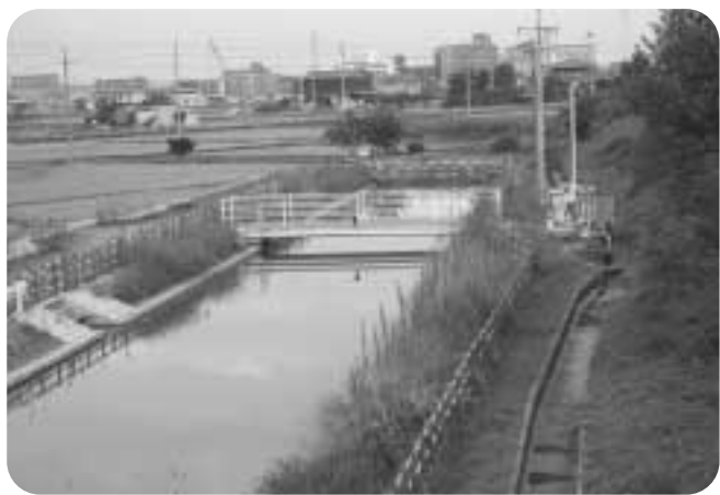
▲停滞している新堀川放水路事業
