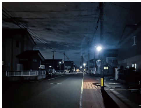
LED化した街路灯
