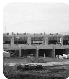
▲牛牧樋門と牛牧排水樋門の進捗
