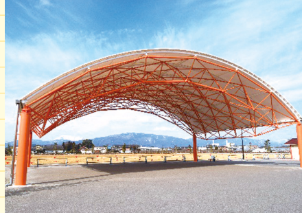
▲ドームシェルター
