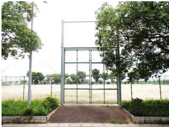
・ グラウンド北側出入口
