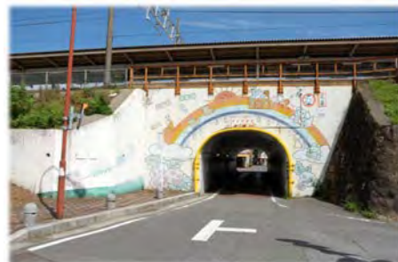
(マンポトンネル)
