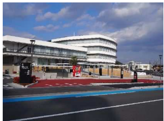
<庁舎内の停留所例(兵庫県高砂市)>
