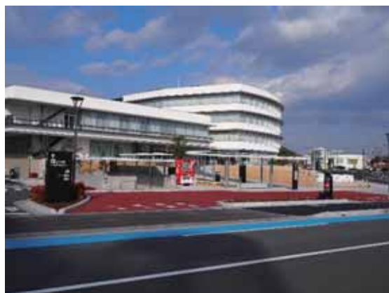
<庁舎内の停留所例(兵庫県高砂市)>
