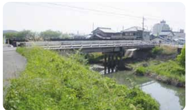
修繕工事 (柳一色橋)
