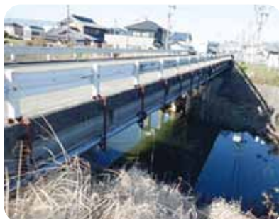
整備前（昭和47年架設）
