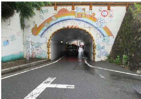
(マンポトンネル)
