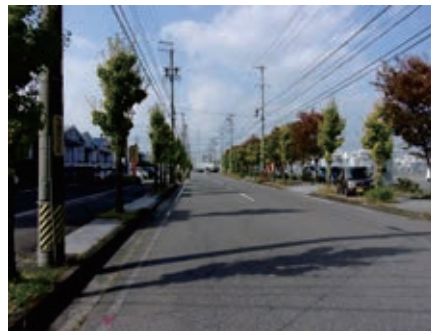
市道 4-1 号線の緑化風景
