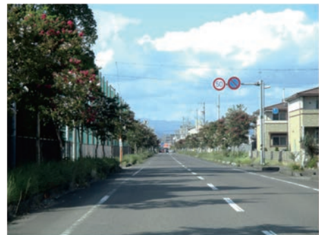
県道 23 号北方多度線 (朝日大学付近)
