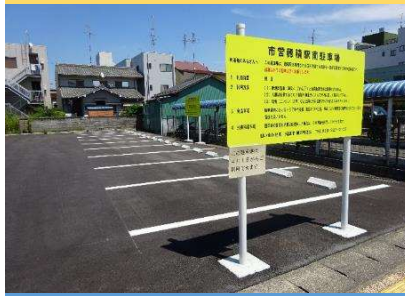
市営穂積駅南駐車場の整備
