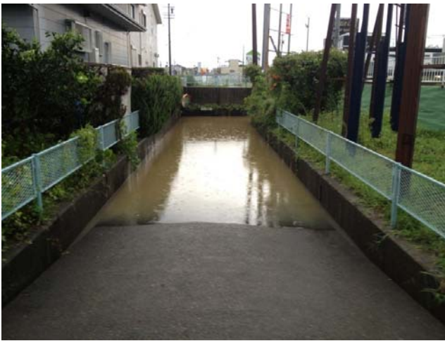
穂積地内(地下道)
