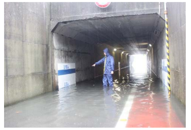
穂積地内(地下道)
