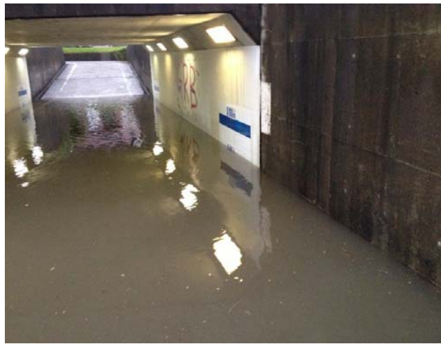
馬場地内(地下道)
