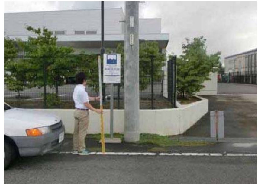
浸水水位 約168cm(現況地盤より)
