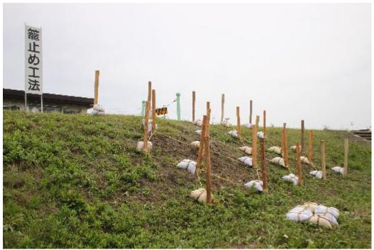
堤防の住居側斜面にひび割れが生じたり、堤防の崩壊が拡大する場合に行う工法です。数m間隔でひし形状に作っていきます。一般には竹を利用しますが、ここでは訓練のため紐で代用しています。
