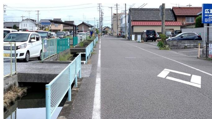
北方多度線と穂積停車場線を繋ぐ市道4-1009号線（郵便局前の通り）は、現状道路幅員が7m程度です。水路を暗渠化し、道路を拡幅することで歩行者と自動車の交通機能を十分に高めることができます。
