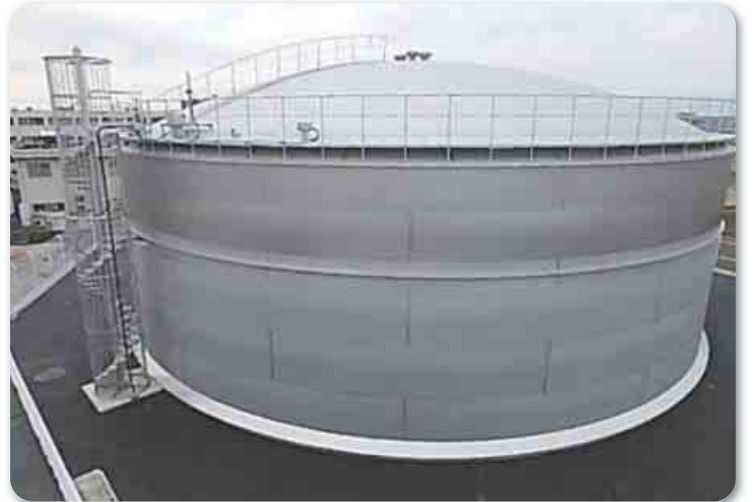
別府水源地の配水池
