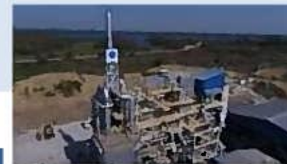
写真 3 左の11: 廃棄物発電設備 (ミャンマー・ヤンゴン)
