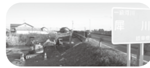
▲犀川改修工事の現場
