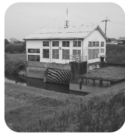
▲老朽化した牛牧排水機場
