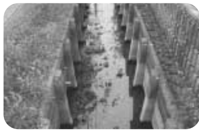
▲水の流れの悪い改良前の排水路
