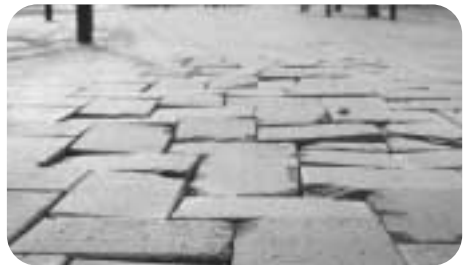
所々破損が見られるレンガ通り
