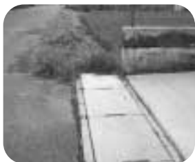
整備が途切れている道路側溝(=古橋にて)
