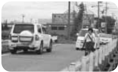
利用が多くすれ違いが危険な柳一色橋
