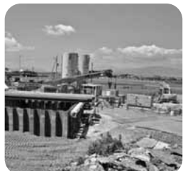
▲整備が進められている新堀川導水路
