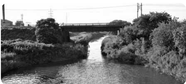
▲歩道の整備が望まれるが…（＝JR東海道線下の五六川）
