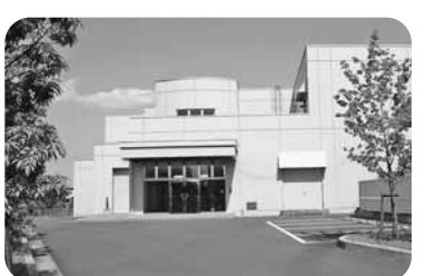
▲水洗化率の向上が望まれる(=アクアパーク別府水処理センター)
