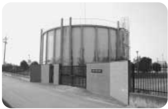
水道供給の重要な水源地（＝隼南水源地）
