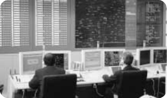
最新の設備を誇る通信司令室(=岐阜市消防本部にて)
