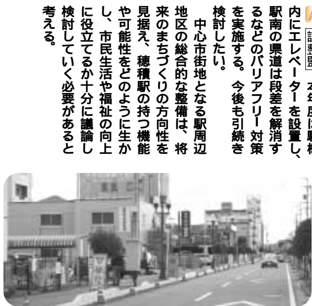
バリアフリー対策工事を行なう駅南の県道
