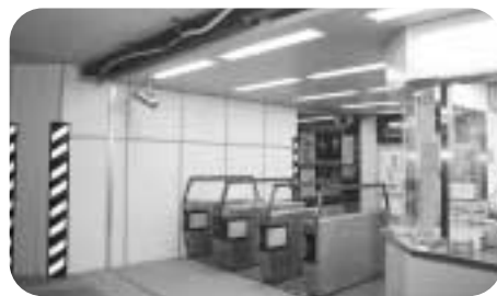
改築工事中のJR穂積駅
