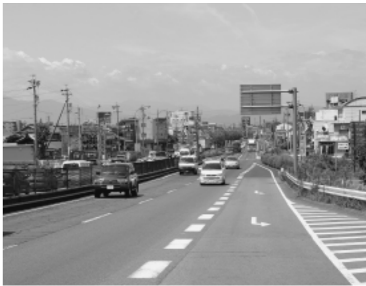
一部6車線化の年内着手が予定される国道21号線＝穂積大橋西詰にて
