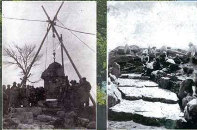
小簾紅園造成工事の様子
