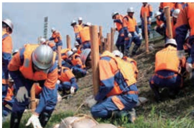
▲籠止め工法を行う消防団員
