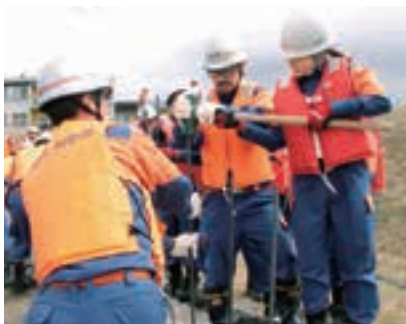
▲鋼杭を打つ女性消防班
